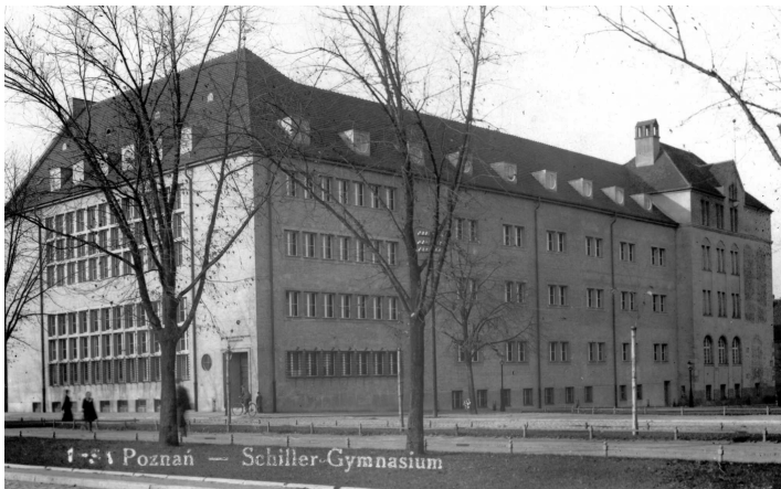
Abb. 2: Das Schiller-Gymnasium in Posen, ca. 1936.
