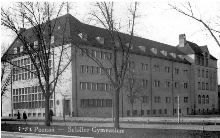
Abb. 2: Das Schiller-Gymnasium in Posen, ca. 1936.
